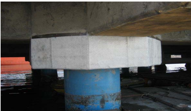
(d) Completion of construction
